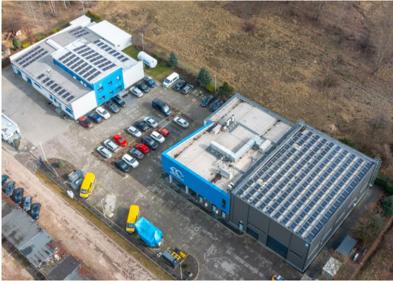
INSTALACJA FOTOWOLTAICZNA 30 I 50 KW
