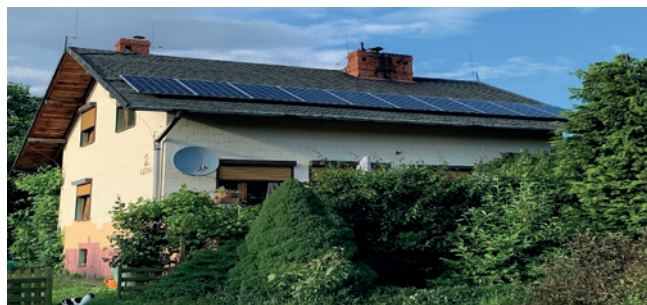
Rys. 1. Instalacja modułów fotowoltaicznych na budynku
