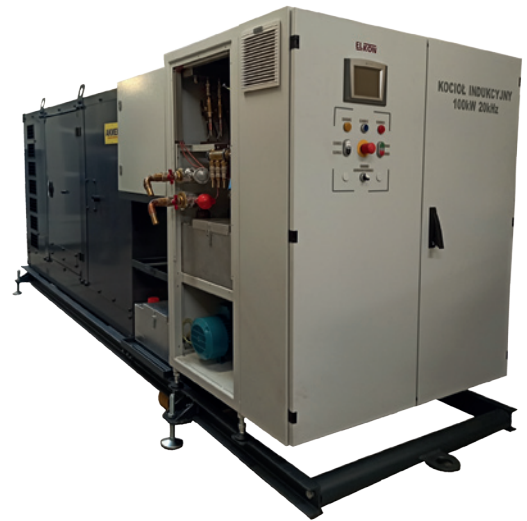
Rys. 4. Autonomiczny zespół elektrociepłowniczy, etap montażu agregatu prądowczego, kotła indukcyjnego, wymiennika gaz/ciecz, wymiennika ciecz/ciecz, pompy obiegowej i szafki sterującej
