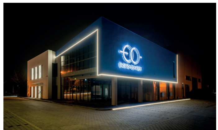
Rys. 10. Siedziba firmy Energocomplex , na dachu zamontowana jest bateria fotowoltaiczna
