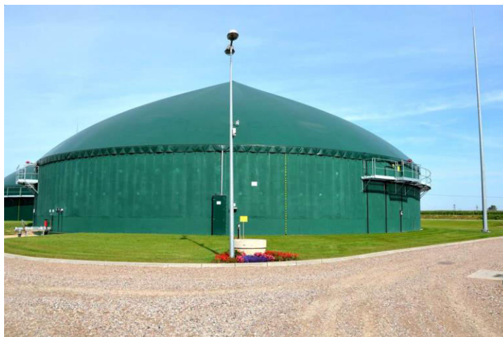
Rys. 5. Membranowy zbiornik dachowy [4]
