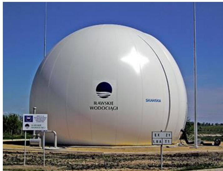
Rys. 1. Zbiornik biogazu o kształcie 3/4 sfery [4]
