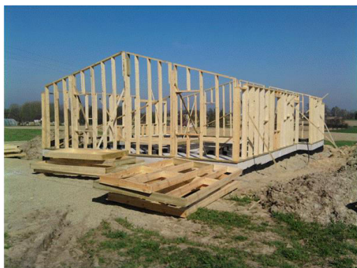
Rys. 5. Dom szkieletowy podczas budowy
