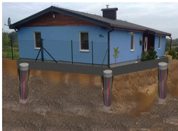
Rys. 9. Rozproszony zasobnik ciepła pełniący funkcję palowego fundamentu domu, który musi być zrealizowany na etapie prac ziemnych przed budową domu.
