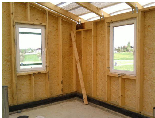
Rys. 6. Konstrukcja ścian domu
