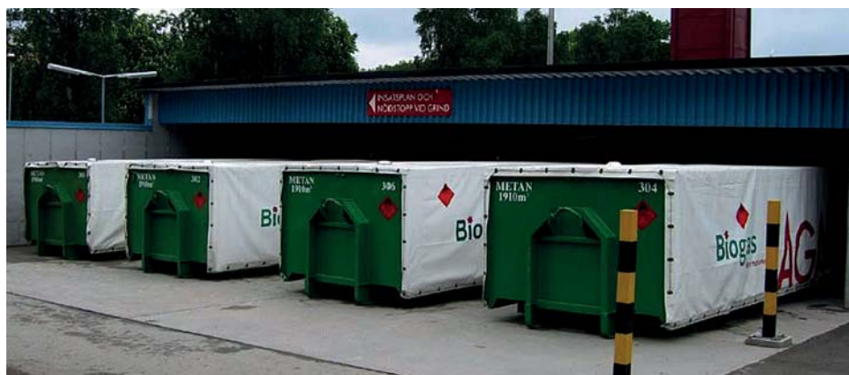
FOT. 13. KONTENERY NAPEŁNIONE BIOMETANEM (FOT. J. NETEROWICZ)
