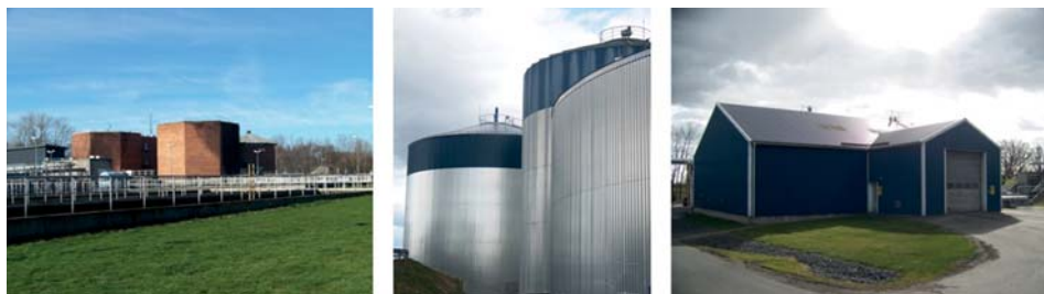
FOT. 12. SZWEDZKIE INSTALACJE BIOGAZOWE: OCZYSZCZALNIA ŚCIEKÓW I BIOGAZOWNIA POFERMENTACYJNA W KRISTIANSTAD W SKANII – KOMORY FERMENTACYJNE I STACJA PRZYJĘĆ ODPADÓW (FOT. B. SMERKOWSKA)
