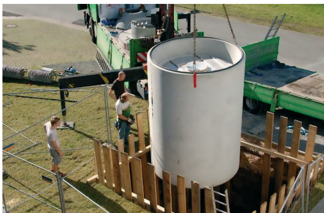
3. Prefabrykowany wodny magazyn ciepła instalowany w gruncie. Źródło: Sonnenhaus Institut
